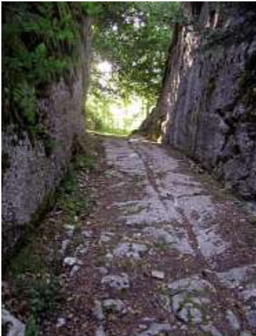
Passage taillé dans la roche à Chalamont, département du Doubs. Cliché J.-M. Yante.
